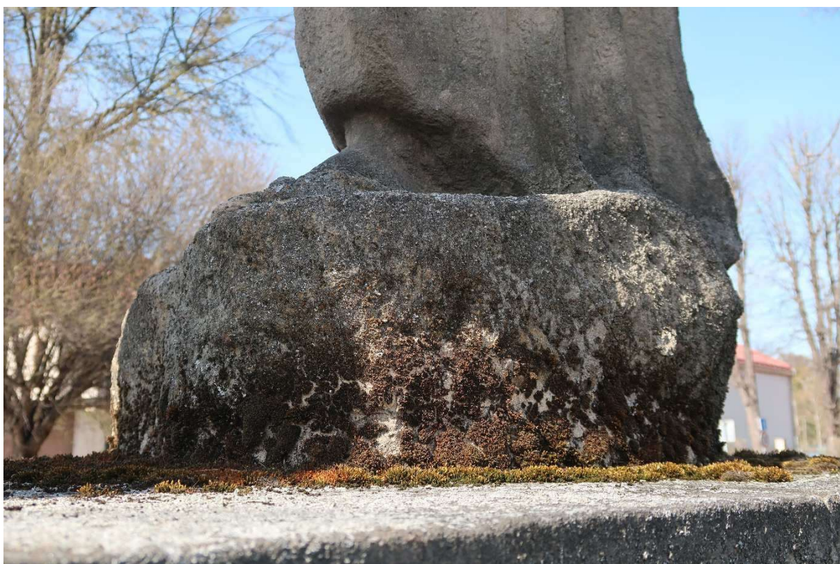
Stav před restaurováním – detail podstavce, mechy a lišejníky v silných vrstvách
