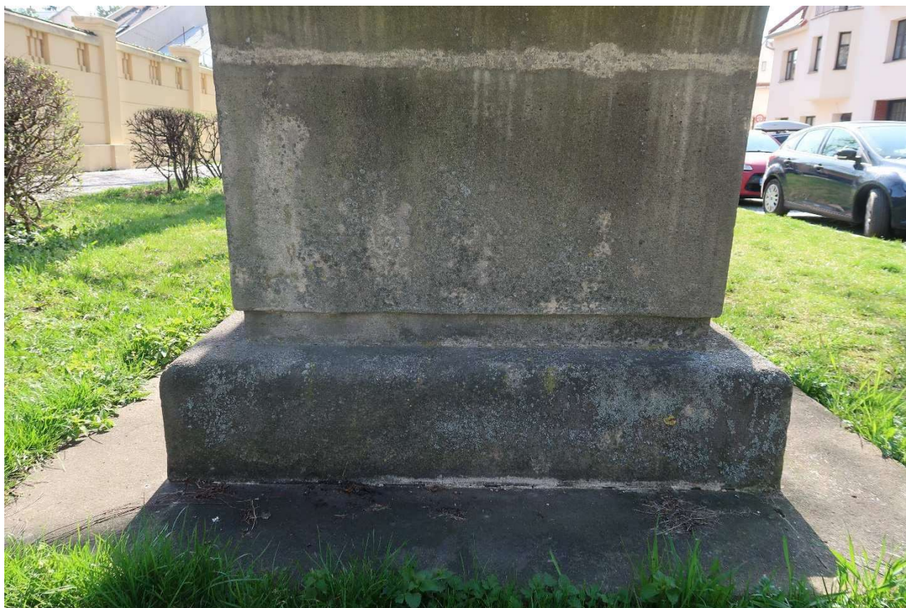
Stav před restaurováním – podstavec, zadní pohled, korozivní změny
