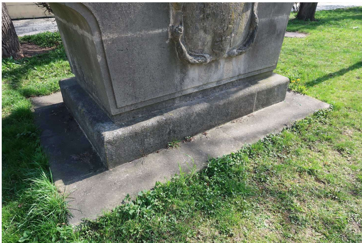
Stav před restaurováním – přední pohled na podstavec, dožilé spárování
