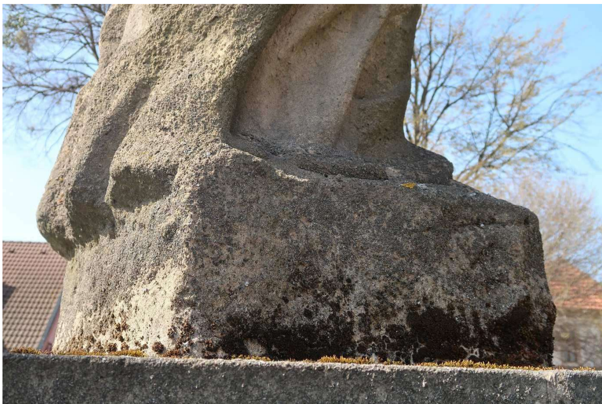
Stav před restaurováním – detail podstavce, mechy a lišejníky v silných vrstvách, praskliny
